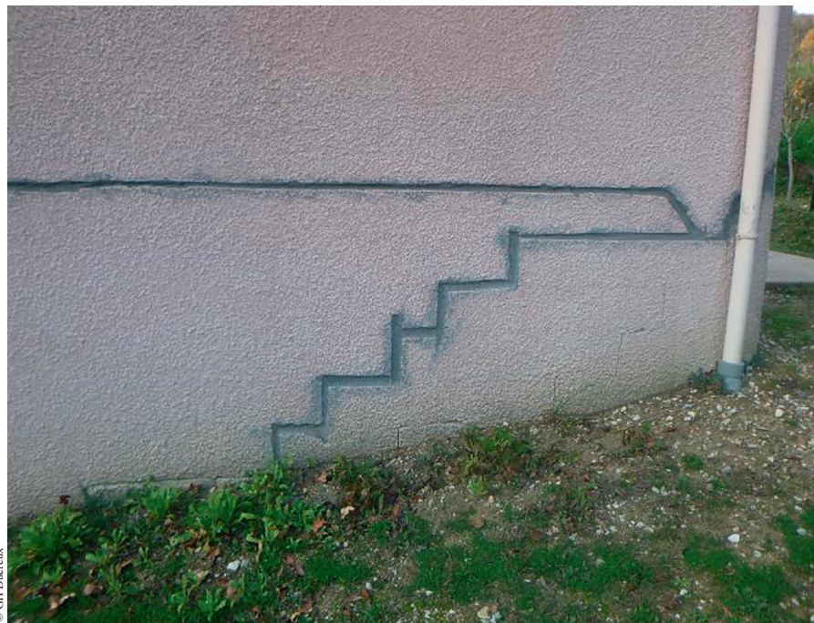
Rebouchage des fissures avant reprise des enduits. Une nouvelle fissure est apparue à gauche de la gouttière – Crest (Drôme).
