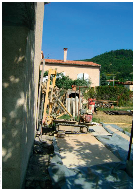
Reprise par micropieux / intervention lourde – Sisteron (Alpes-de-Haute-Provence).
