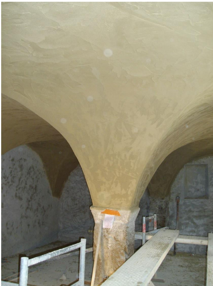
Restauration des voûtes - 2008
