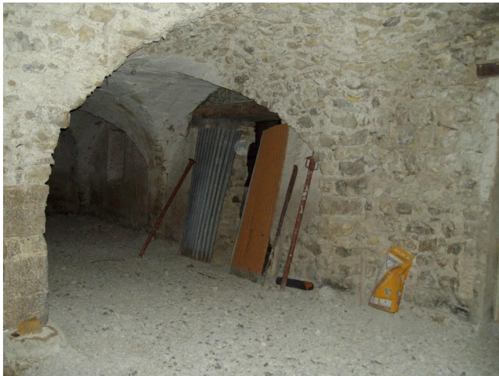
La bergerie du sous-sol en 2008 – partie sud
