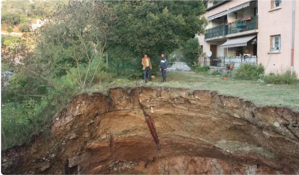
Illustration n° 7 : effondrement au Luc (83)
