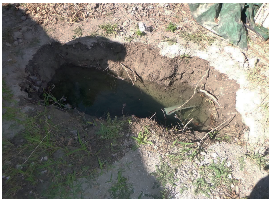
Niveau de l'eau dans le sol remonté à 20 cm de la surface en période estivale (image 6).
