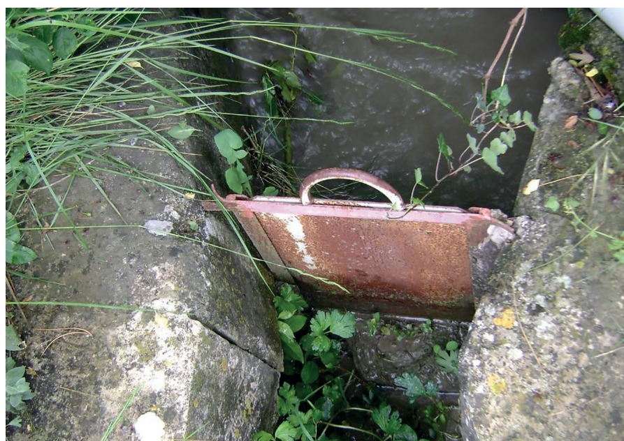
Vue d'une martelière permettant d'ouvrir ou fermer une branche d'un canal (image 1).
